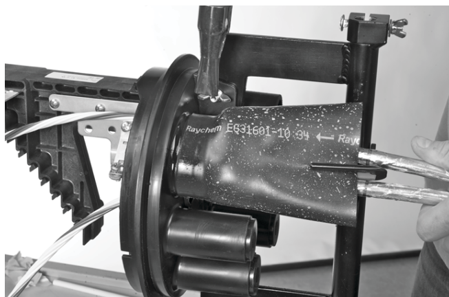
8.5 Start krympingen ved boksbunnen. Krymp ned mot kablene. Krymp til den grønne thermo-indikatoren på satsen endrer farge til sort. Benytt godkjent krympeverktøy.
