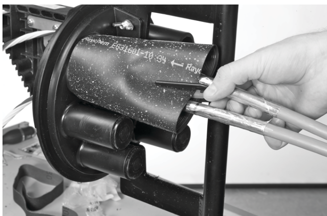
8.4 Monter limclipsen mellom kablene.
